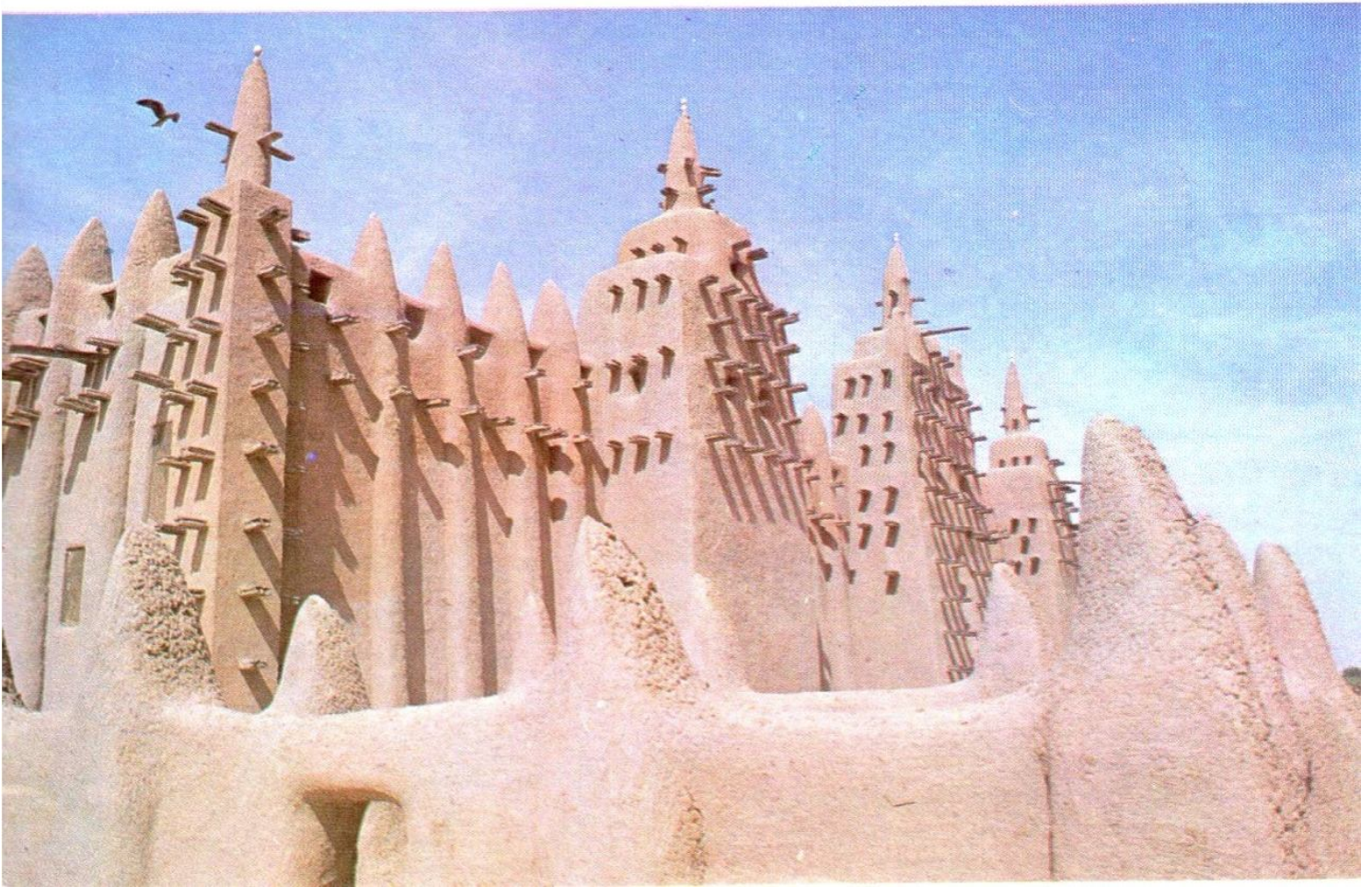
Fachada de la mezquita de Djenné, reconstruida recientemente, según el modelo del siglo xiii (abajo)
